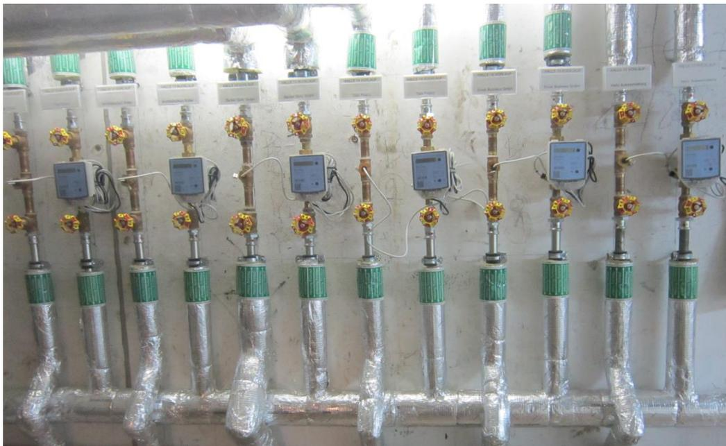
Außerdem ist bei handwerklich erstellten Messstellen der Vor- und Rücklauf zwingend mit einer Beschilderung über die Flussrichtung zu kennzeichnen:
